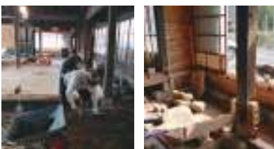
↑大黒柱を含む柱の傾きも直したという。もはやプロのDIY職人
